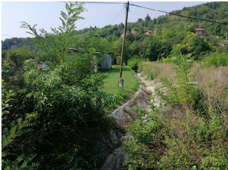
slika 19. uređeni dio pritoka potoka Branovec
