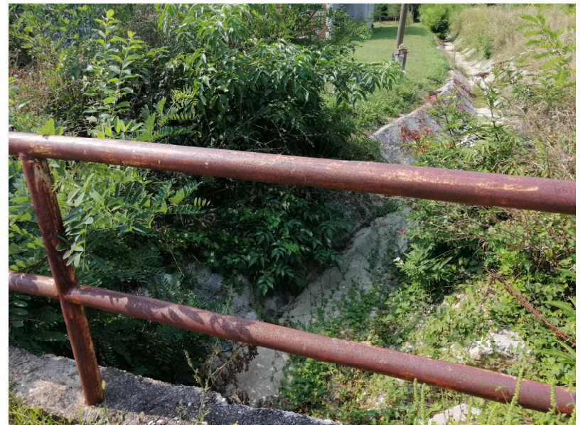
slika 20. propust ispod nerazvrstane cesta Lazina - Branovec
