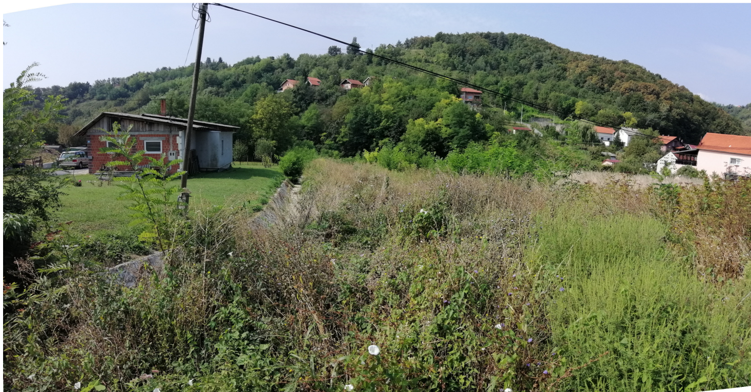
slika 18. uređeni dio pritoka potoka Branovec
